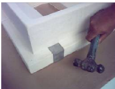
Ajustar a ancoragem no Bloco Visor Moldafrax
